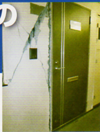
地震で歪んだドアの実例
